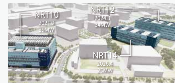
首都圏NRTキャンパス全体 100MW規模（追加開発含む）
